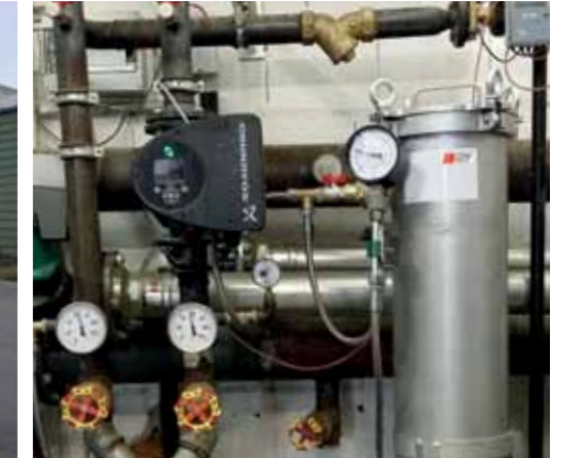
Einsatz im Nebenstrom
